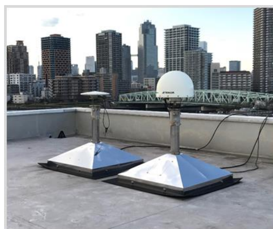
図 3.2 屋上の静止点測位で使用した GNSS アンテナ
