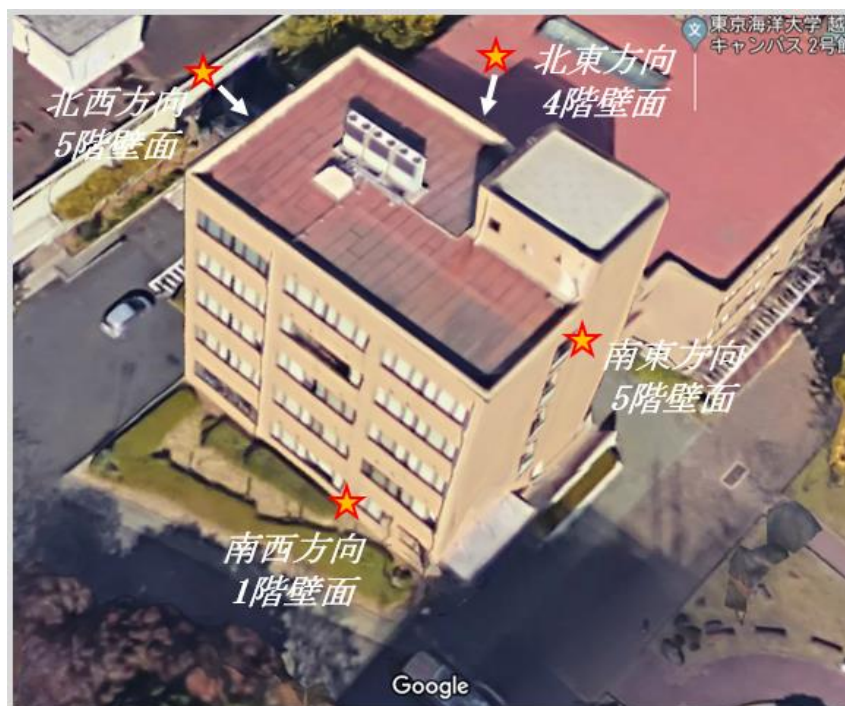
図 4.4 アンテナ設置場所
