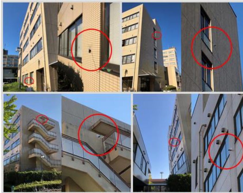
図 4.5 実験状況（左上:南西，右上:南東，左下:北西，右下:北東）
